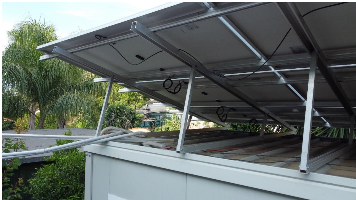
Figura 17: Particolare strutture di sostegno dei moduli fotovoltaici
