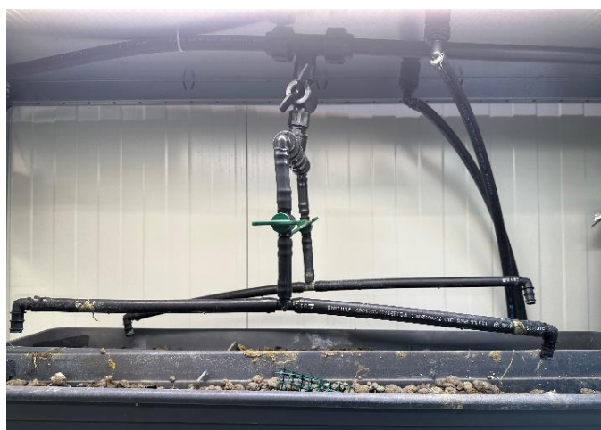
Figura 46: Dettaglio tubazione in PVC per irrigazione
