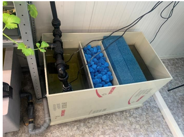
Figura 42: Dettaglio impianto di filtraggio
