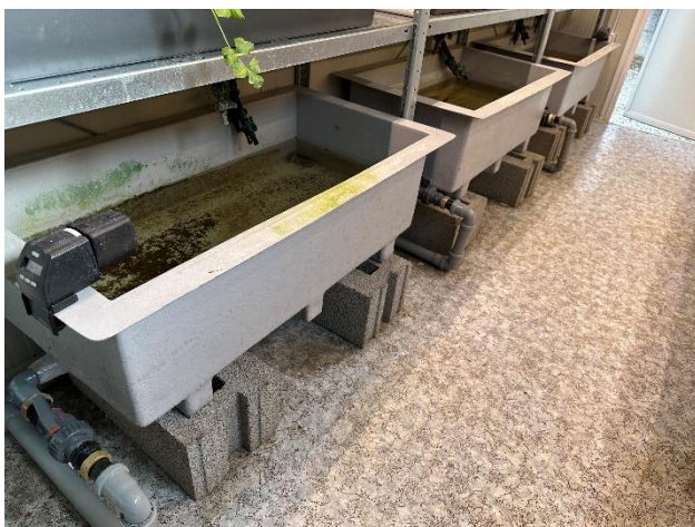
Figura 40: Dettaglio vasche con sistema di distribuzione mangime temporizzato
