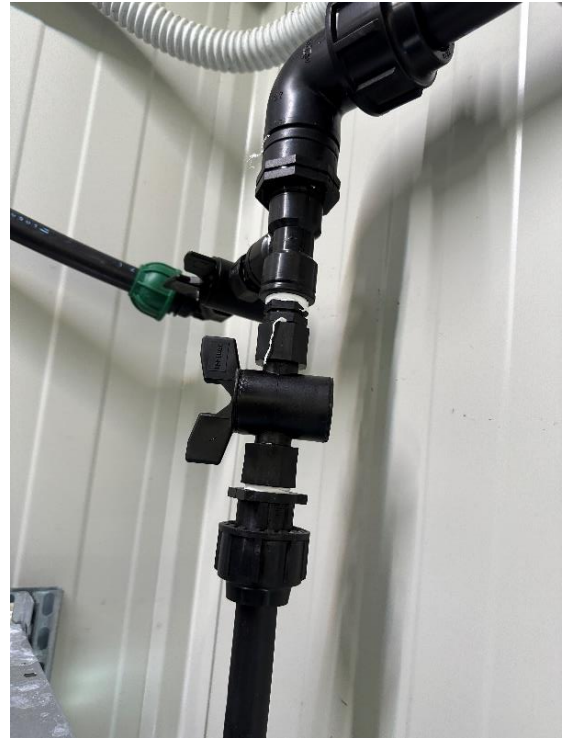
Figura 47: Dettaglio sistema di regolazione di flusso
