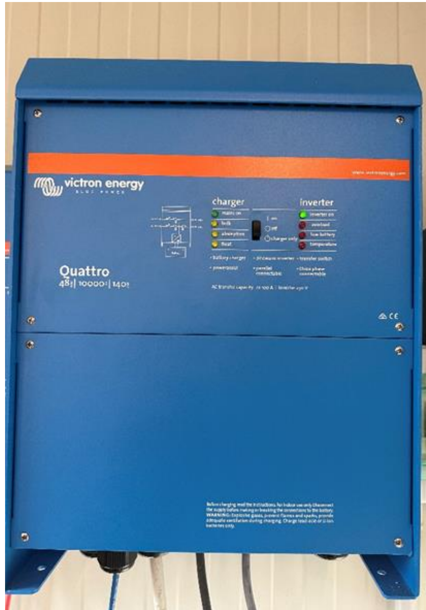
Figura 26: Inverter Victron Quattro
