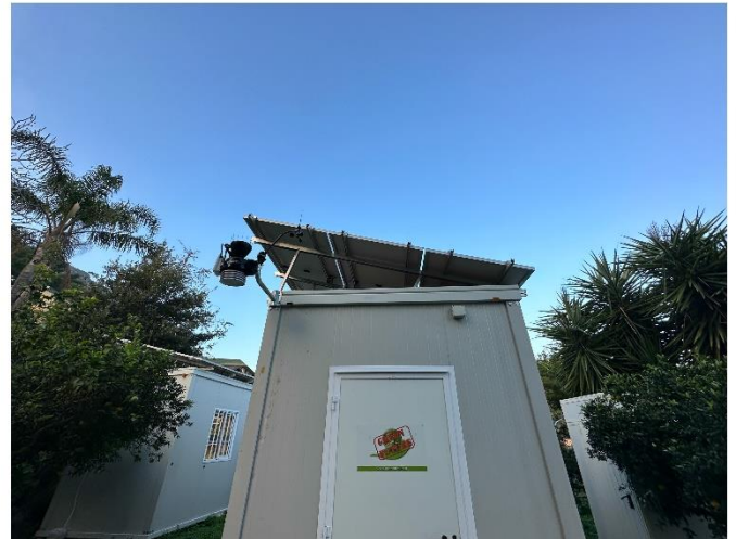
Moduli fotovoltaici e strutture di supporto
