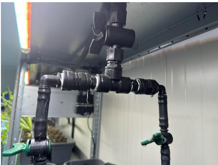
Figura 48: Dettaglio sistema di regolazione di flusso
