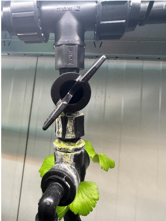
Figura 47: Dettaglio sistema di regolazione di flusso
