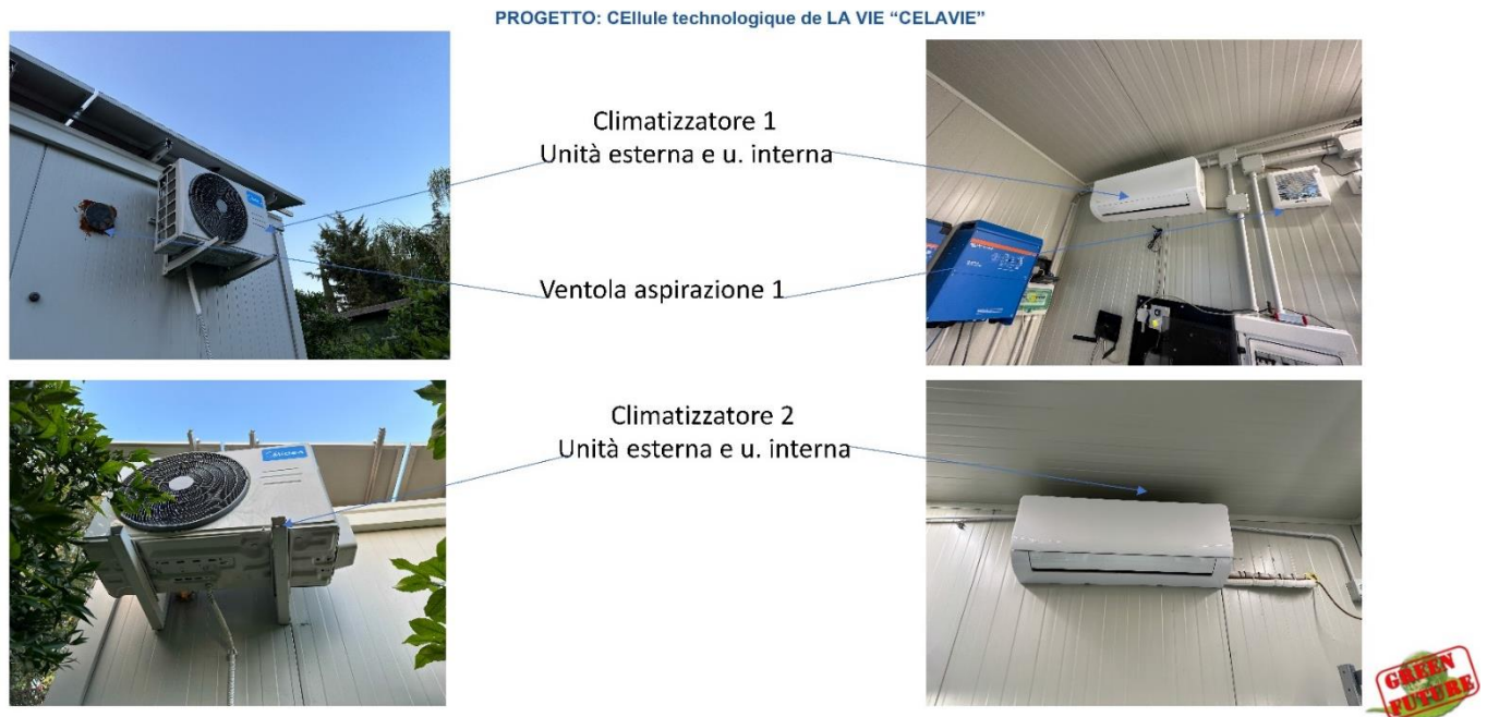
Figura 9: posizionamento blocco motore pompa di calore
