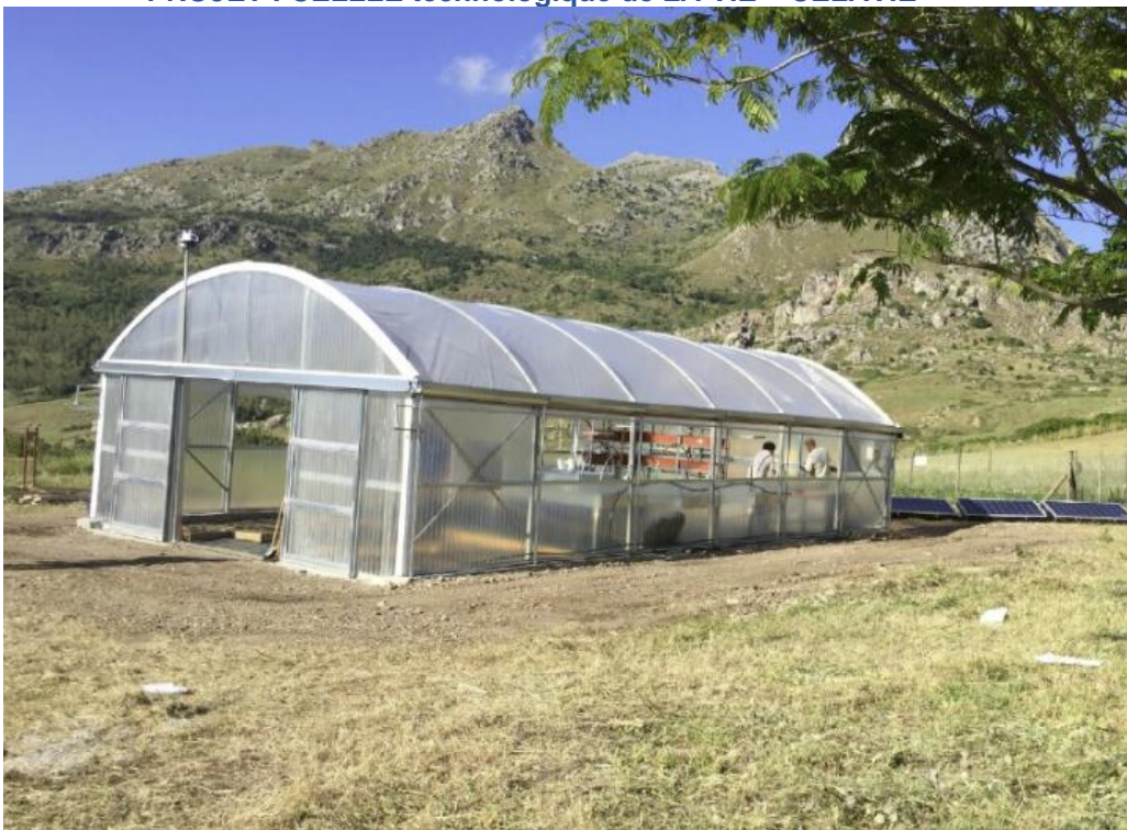
Figure 20 : État final de la serre
